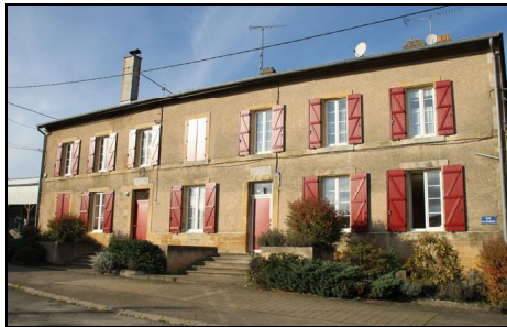
C'est dans la partie droite de ce bâtiment que la cantine prendra place. Photos RL
