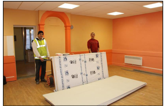
Les employés municipaux sont à l'œuvre dans le futur réfectoire.
